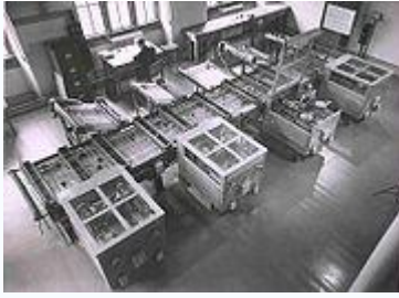
Дифференциальный анализатор, Кембридж, 1938 год
